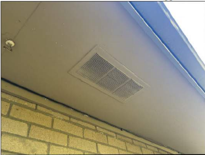
Soffit vent
